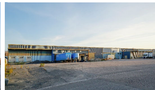
Teollisuuskiinteistö alueen eteläpuolella
