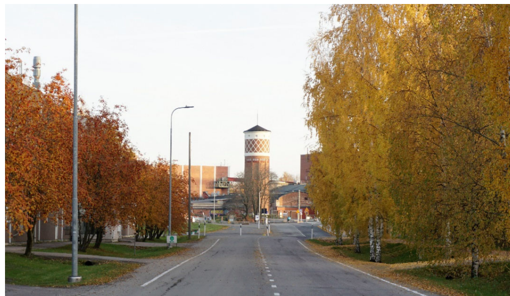
Näkymä Tehdaskartanonkatua kaakkoon. Päättänä tehtaan vesitorni.
